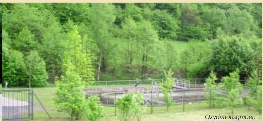
Betriebsgebäude und Schlammstapelbehälter
