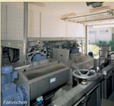
Rechengutwäsche und Kolbenpresse
