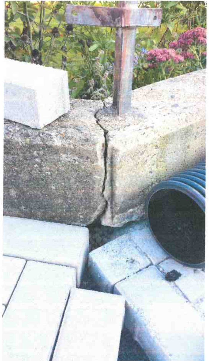
Bild 4: Zustand während der Pflasterarbeiten
