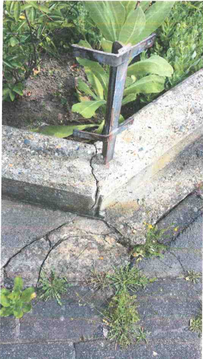
Bild 3: Mauerecke Einmündung „Hinter den Höfen“ in „Kapellenweg“, Zustand vor der Baumaßnahme
