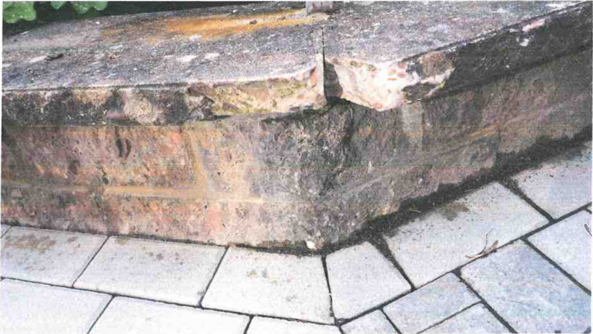
Bild 1: Mauerecke 1 Einmündung „Pilzenrain“ in „Hinter den Höfen“
