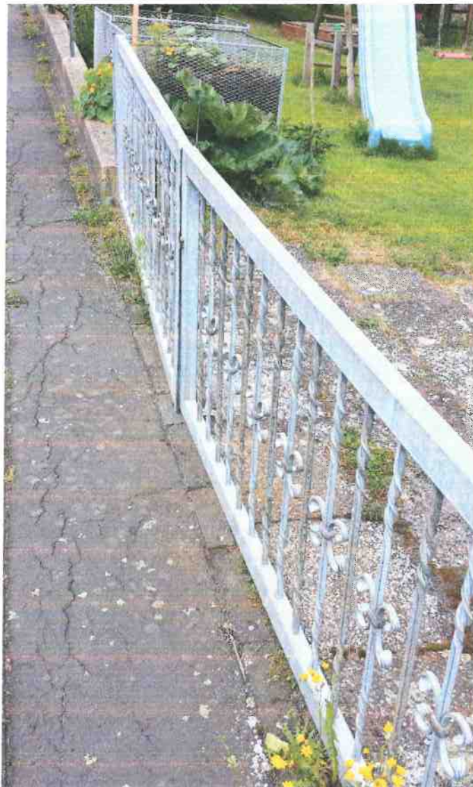
Bild 6: Tor hintere Grundstückseinfahrt „Kapellenweg“, Zustand vor der Baumaßnahme
