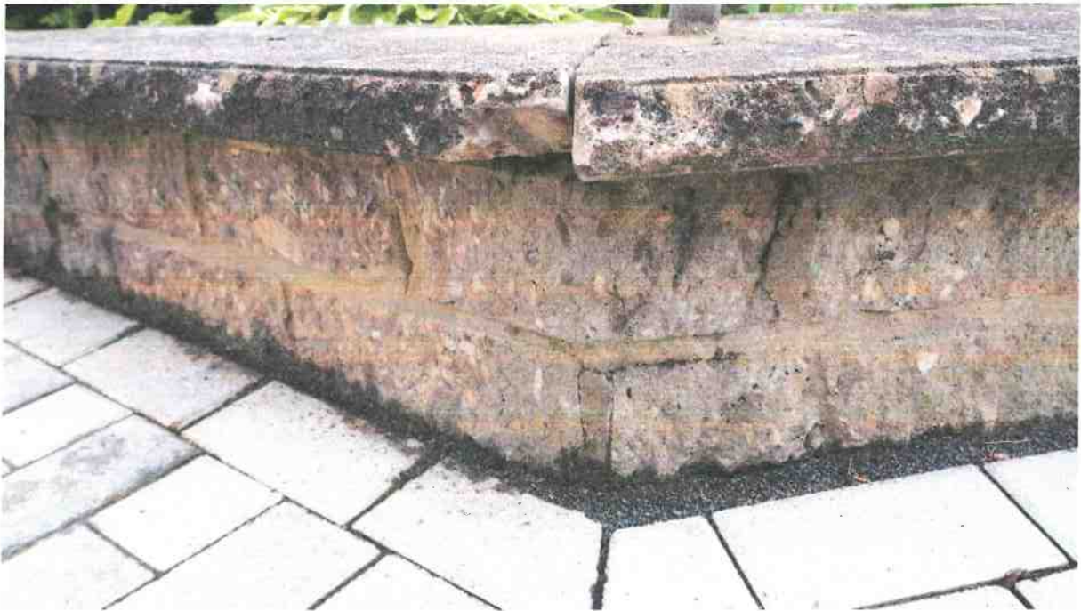
Bild 2: Mauerecke 2 Einmündung „Pilzenrain“ in „Hinter den Höfen“
