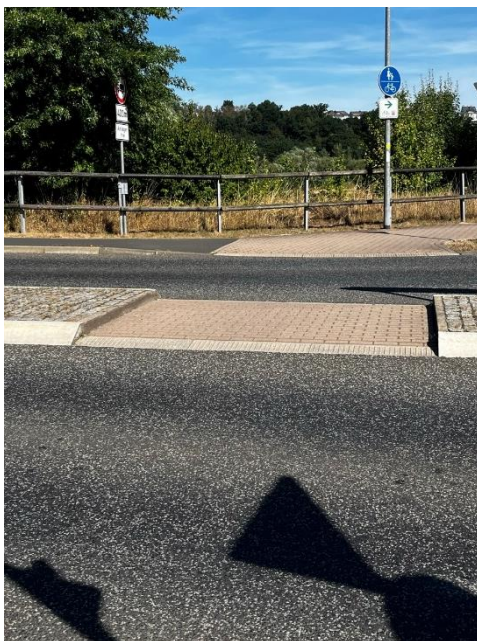
Fehlende Markierungen, keine vollständig barrierefreie Querung (vgl. Maßnahme Q8)
