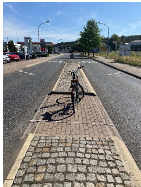
Fehlende Markierungen, keine vollständig barrierefreie Querung, keine ausreichende Breite (vgl. Maßnahme Q15)
