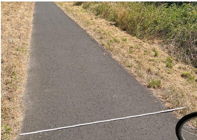
Gemeinsamer Geh- und Radweg im Zweirichtungsverkehr erfüllt nicht die Anforderungen von min. 2,5 m Breite (hier etwa 1,9m, vgl. Maßnahme W1)
